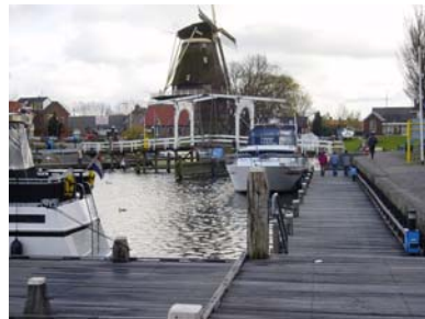
Steigerhoogte 0,50 tot 0,70 meter
